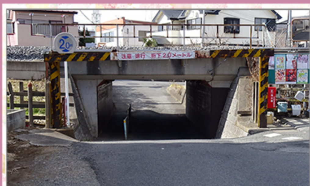
10 東武アーバンラインのガード
